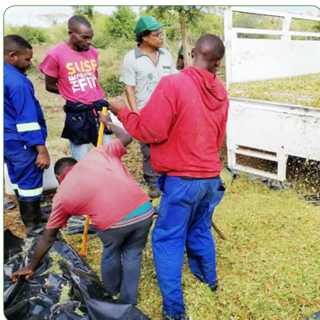
Enchimento e Compactação do Material picado
